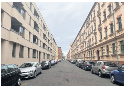
In der Henricistraße im Stadtteil Altlinde hat Propos eine langjährige Lücke passend zur Nachbarbebauung geschlossen. Quelle: Immobilien Zeitung, Urheber: Sabine Gottschalk
