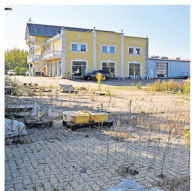
Muss weichen: das markante Gebäude des ehemaligen Autohauses. Foto: G. Redepenning
